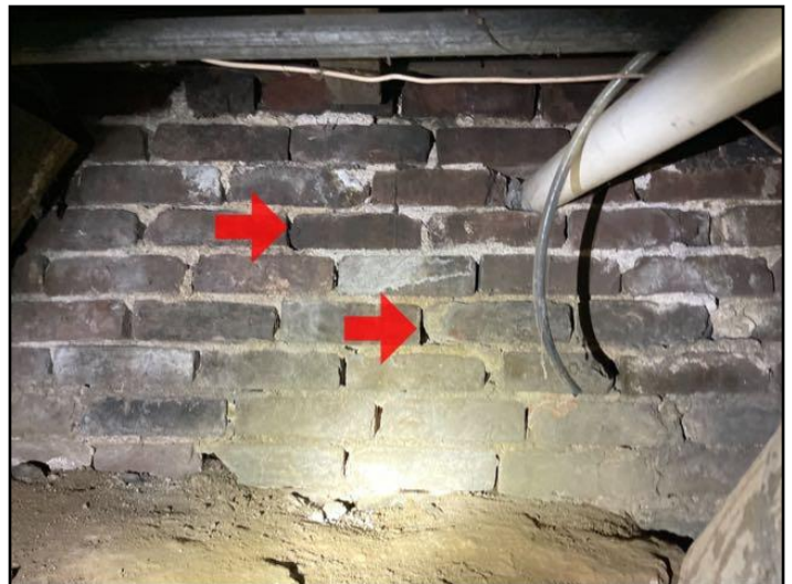
60. Mortar deterioration
